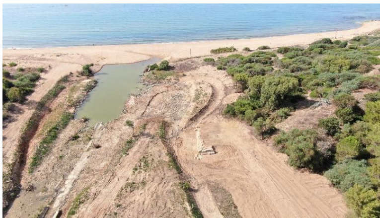
Fig.11 - Area di foce del fiume Cottone, alla cui destra è visibile la struttura portuale, emersa a luglio 2023, durante l'esecuzione dei lavori di ingegneria naturalistica per la riattivazione del reticolo idrografico.
